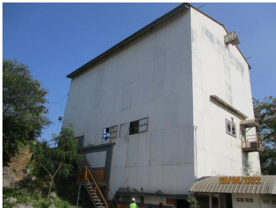
รูปที่ 8 ผนังปิดคลุมมิตชิดโรงโม่หิน
